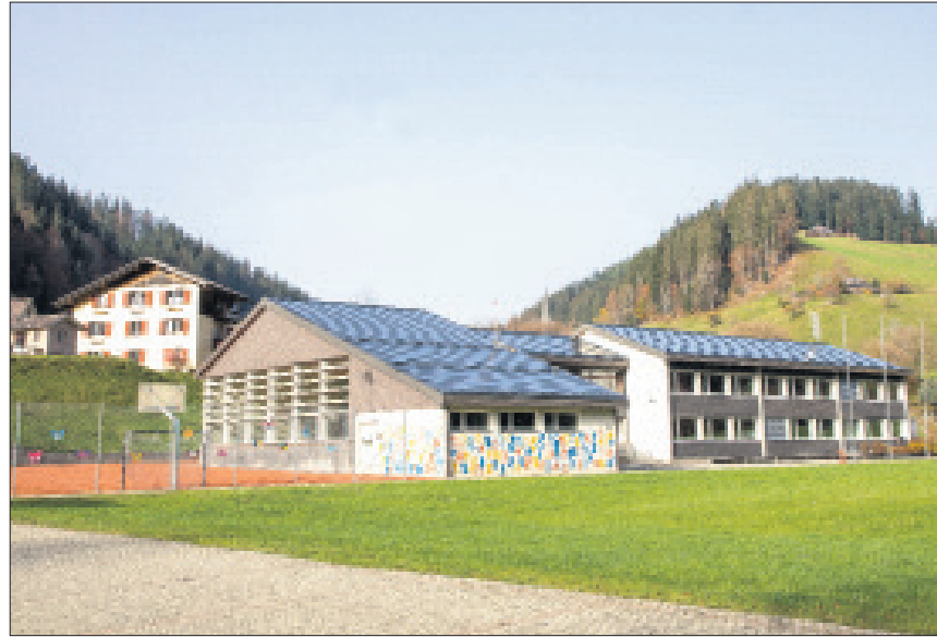
Bald schon sollen die ersten Arbeiten zur Sanierung des Schulhauses in Angriff genommen werden. Daniel Schweizer
